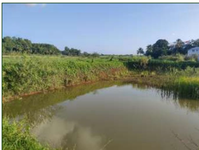
Figure 5 : Vue sur la partie en eau du réservoir
