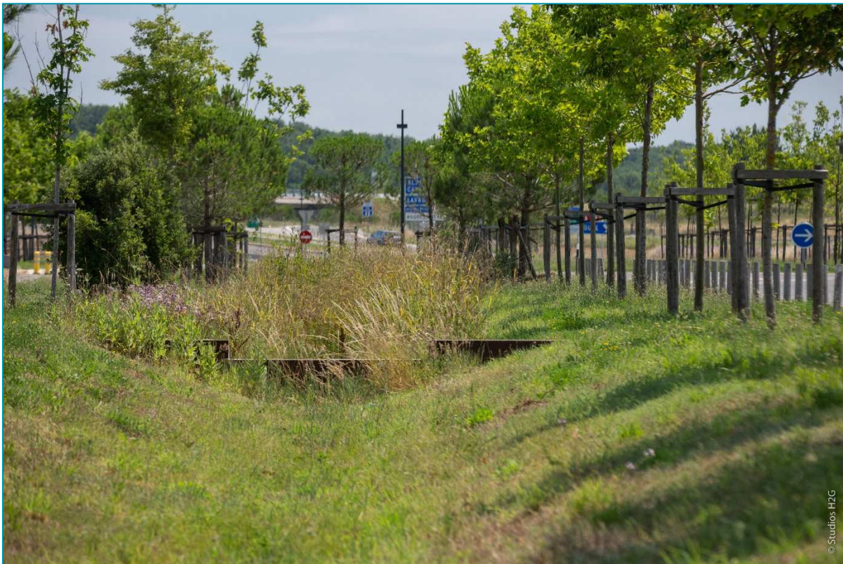
© Portes du Tarn, noue paysagère de la zone de développement d'activité des Portes du Tarn, 2020
